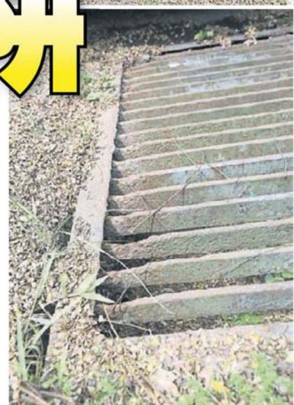
■八打灵再也第51区工业区的沟渠盖已生锈，且有下沈的迹象。
